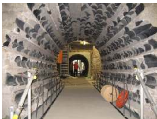
BU: Neu gebohrter Tunnel
