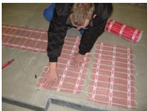
BU: Die selbstklebende Trägerschicht vereinfacht die Fixierung des THERMO BODEN
