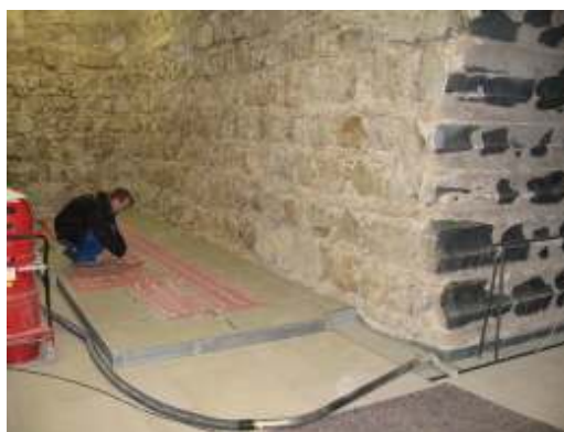
BU: Monteur der Firma Baeth bei der Verlegung des AEG THERMO BODEN
