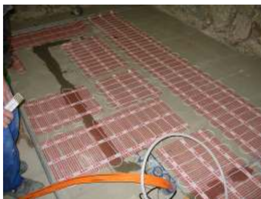
BU: Fertig verlegte Heizmatte
